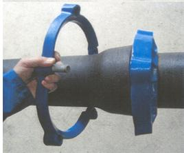
Mettre un boulon pour lier les demi-bagues qui se placeront facilement derrière l'emboîtement.
