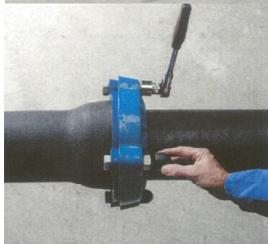
Serrer les boulons de manière alternée. Pour le couple de serrage, voir la table ci-dessous. Placer les capuchons anticorrosions.
