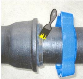
Placer le jonc contre le front de l'emboîtement et lubrifier le jonc.
