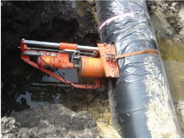
1) Mise en place de la carotteuse sur le tuyau fonte
