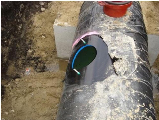
3) Protection de la découpe avec le kit époxy Resicoat RS
