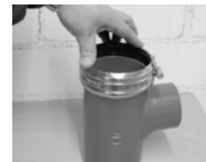
1. Kompletten Verbinder bis zum mittleren Distanzring der Dichtung auf das Rohrende oder Formstück aufchieben.
