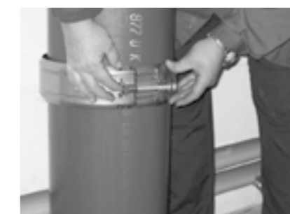
4. Schraubenkopf mit Tellerscheibe in Spannkopf einhängen.
