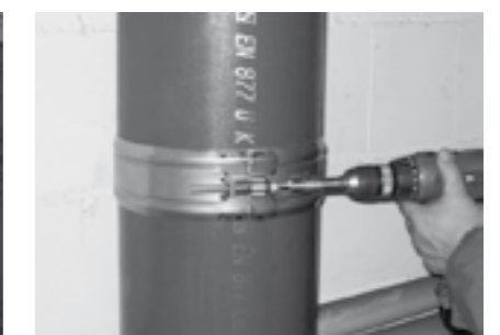
5. Innensechskantschraube mit Steckschlüssel, Handratsche oder Schlagschrauber anziehen, bis beide Spannköpfe zusammenstoßen.
