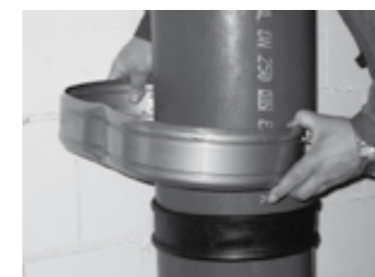
3. Gehäuse umlegen, maximal zweimal auf 120% des Rohraußendurchmessers öffnen.
