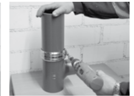
3. Innensechskantschraube mit Steckschlüssel, Handratsche oder handelsüblichem Akkuschauber anziehen. Dükorapid® DN 50–150: 10–20 Nm, bei Zusammenstoßen der Spannköpfe nicht weiter anziehen. Dükorapid® DN 40 und 200, Rapid Norma, Rapid Inox, Rapid MSM: bis beide Spannköpfe zusammenstoßen. MLetec Rapid: 15–25 Nm
