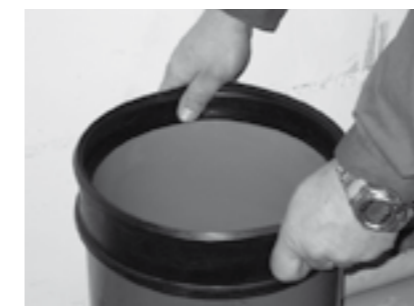
1. Dichtmuffe bis zum mittleren Distanzring aufstecken.
