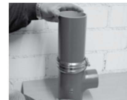
2. Das nächste Rohrende oder Formstück von der anderen Seite in die Verbindung einschieben.
