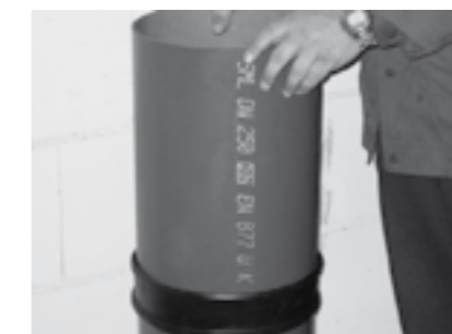
2. Zweites Rohrende oder Formstück einschieben und bündig auf Distanzring aufsetzen.
