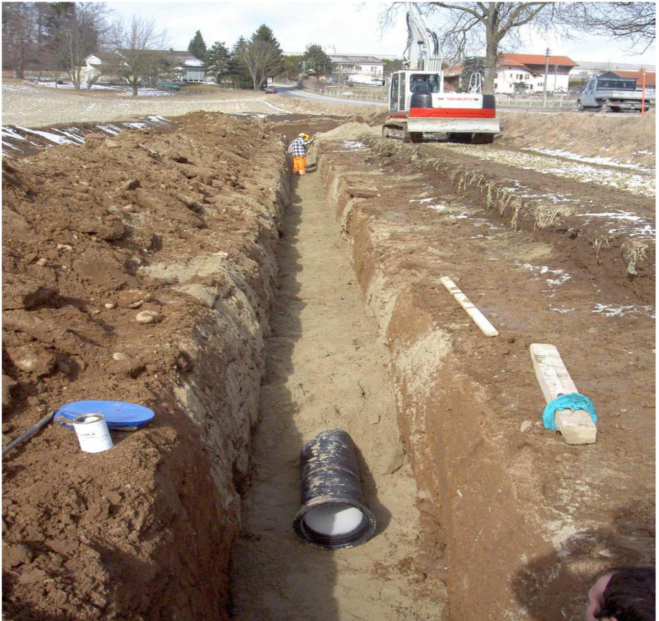
Chantier Suisse : tuyaux K9, 1100 mt DN 500 (AEP)
