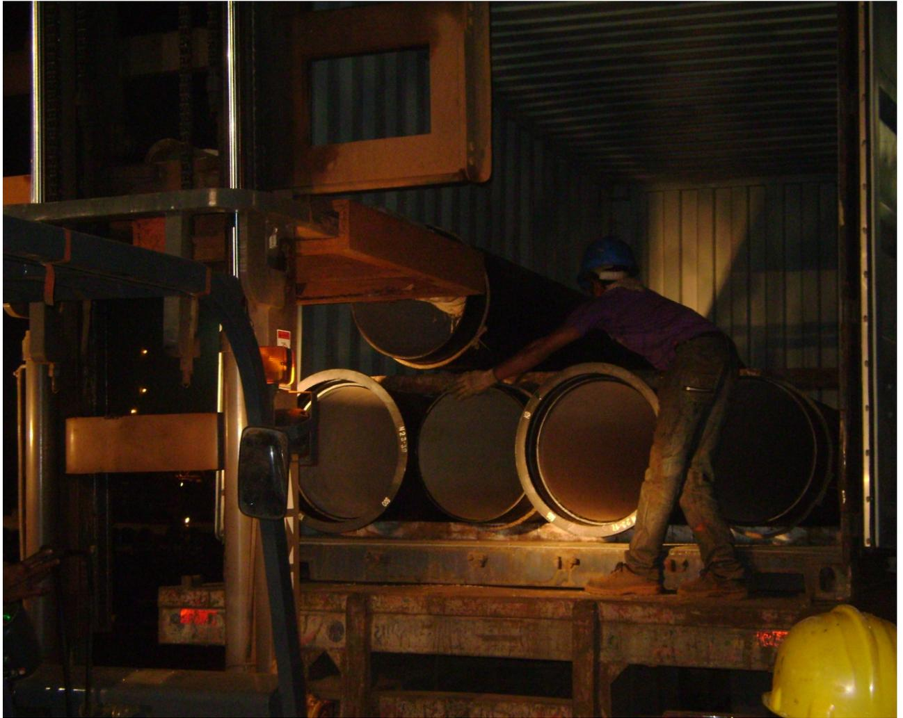
Chantier La Réunion : tuyaux K9, 7000 mt DN 350 & DN 400 mm (AEP/Eau brute)
