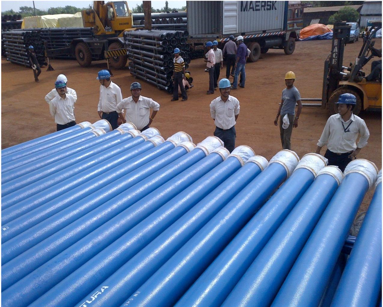
Chantier Côte d'Ivoire : tuyaux C40, 52000 mt DN 250 & DN 300 mm (AEP)
