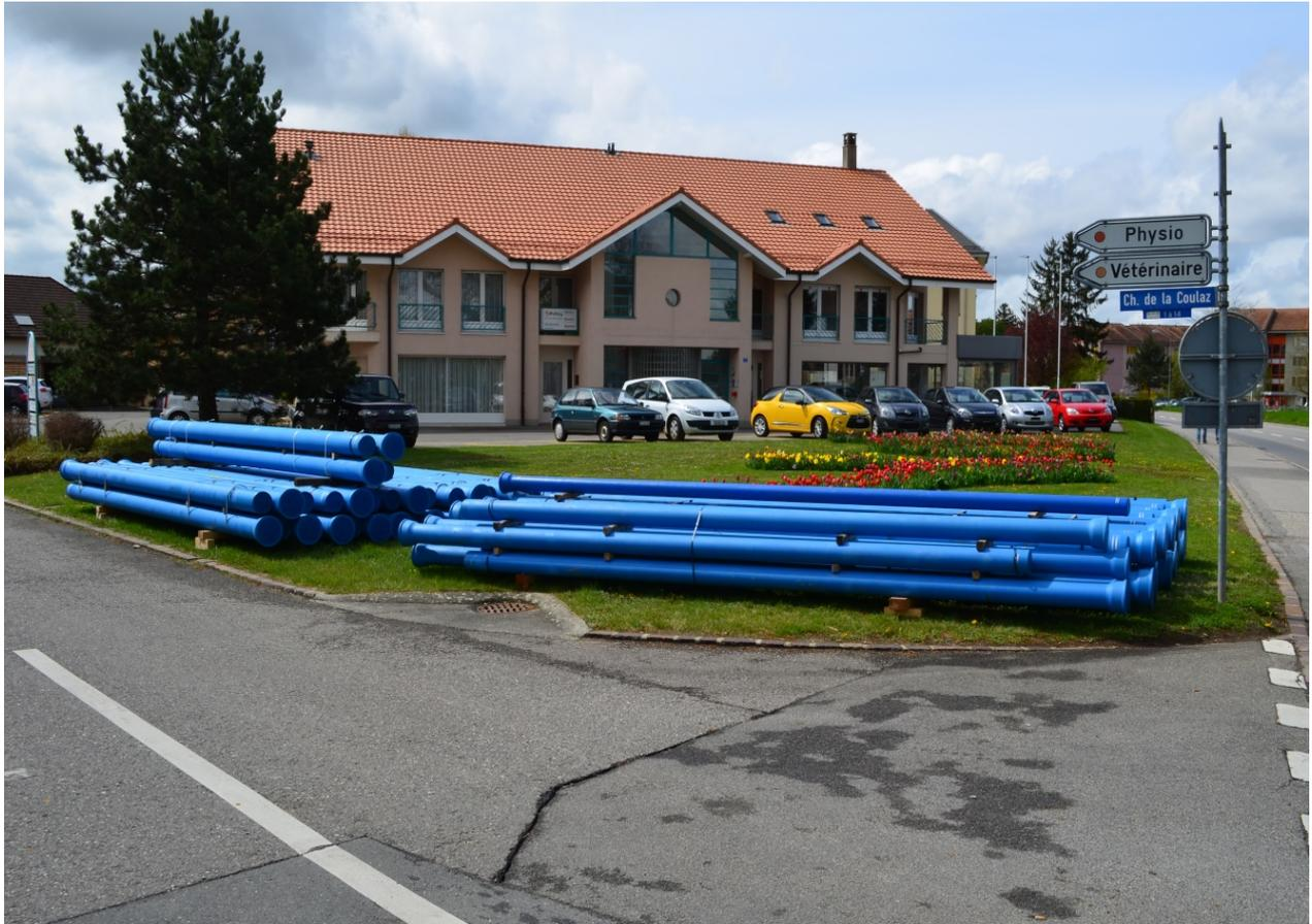
Chantier Suisse : tuyaux K9, 1700 mt DN 150 & DN 200 mm (AEP)
