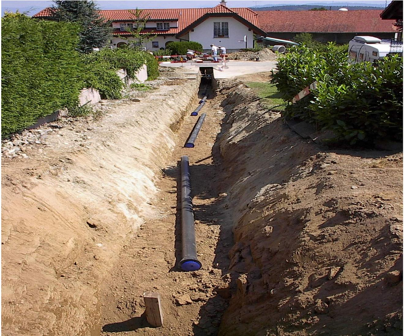
Chantier Italie : tuyaux C50, 1200 mt DN 200 (AEP)
