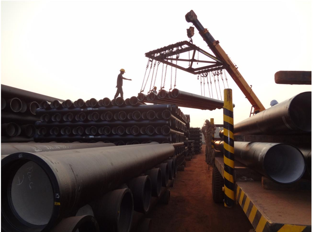
Chantier Algérie : tuyaux K7 & K9, 43000 mt DN 500 mm (AEP)
