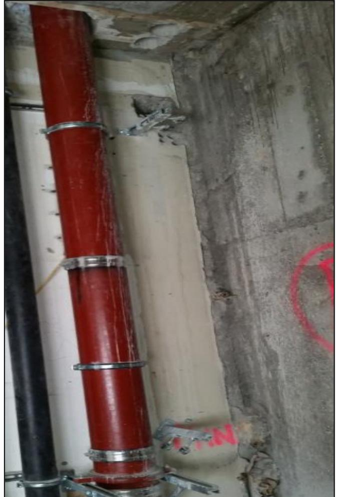
*Nouvelle colonne en fonte SML en DN 300*
